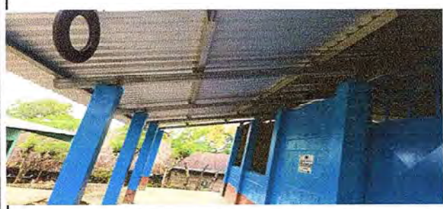
Foto 5: se observa las vigas y costaneras de la escuela se cambio por la estructuras metalicas igualmente se quedo al 100%
