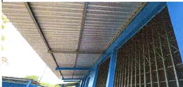
Foto 3: se observa la estructura y cubierto de lamina troquelada y se quedo al 100%
