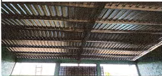
Foto 1: se observa la costanera de la escuela se cambio y se quedo al 100%
