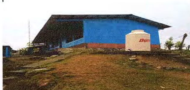
Foto 2: se observa la pared de la escuela esta pintada pero se quedo al 30% para terminar de pintar por motivo que no se alcanzo el dinero para comprar pintura
